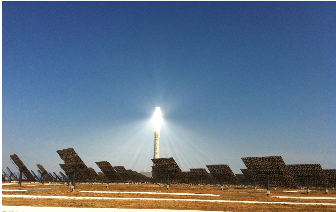
Gemasolar – Fuentes de Andalucia, Seville, Spain
